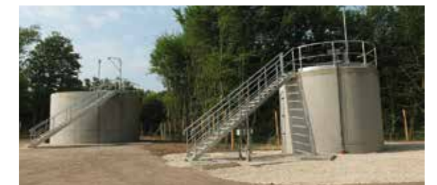
Station d'épuration de Mesland
